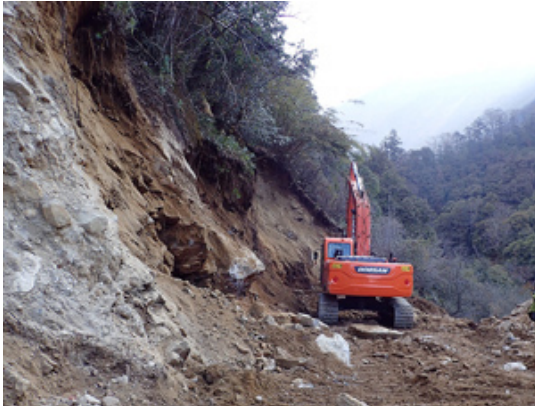
重機が活躍する道路整備の風景。開通が待たれます
