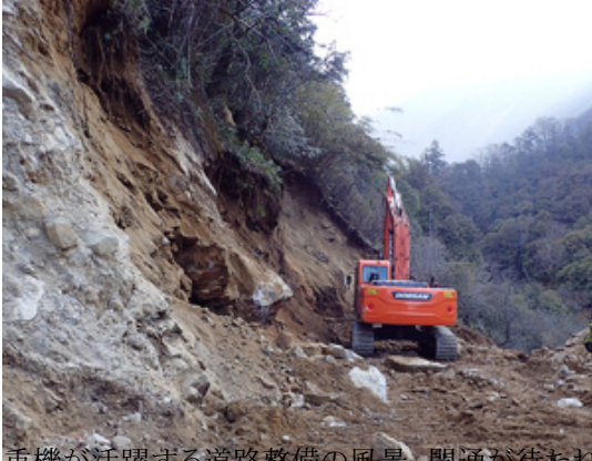
重機が活躍する道路整備の風景。開通が待たれます
