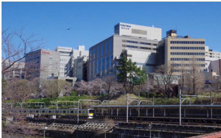
写真中央のアルカディア市ヶ谷(私学会館)。手前の外濠公園が桜の名所
