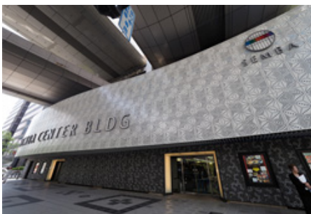
屋上を阪神高速13号東大阪線および中央大通の高架道路が通っている船場センタービル
